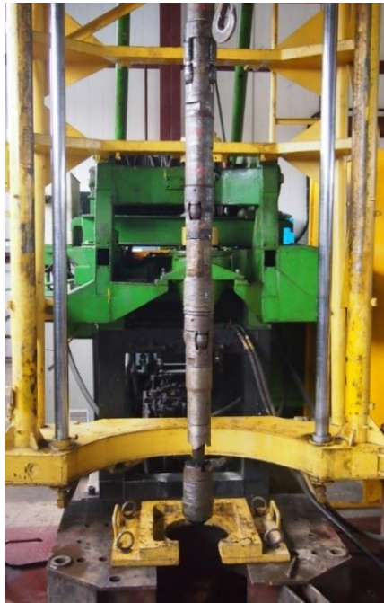
Рис. 9. Испытания извлекаемого башмака и посадочной «головки» ПП на стенде института «ТатНИПИнефть». Посадочная «головка» и башмак отсоединяются от ПП вращением бурового инструмента вправо по специальной резьбе
