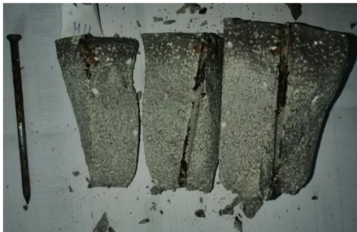
Рис. 1. Коррозия металла в магниезиальном цементе
